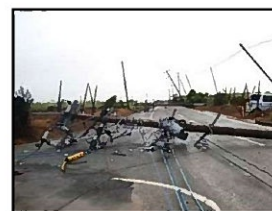
台風による電柱倒壊
